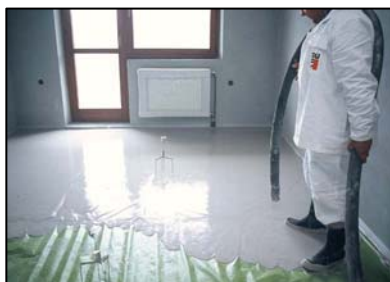
Foto 9: lití potěru bez podlahového vytápění
