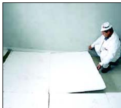
Foto 5, 6: montáž okrajové dilatační pásky, pokládání tepelně izolačních desek
