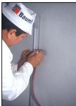
Foto 8, 9: vyznačení vodorovné roviny pro odměřování hladiny litého potěru
