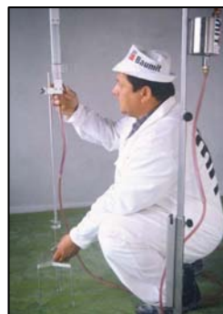
Foto 8, 9: vyznačení vodorovné roviny pro odměřování hladiny litého potěru
