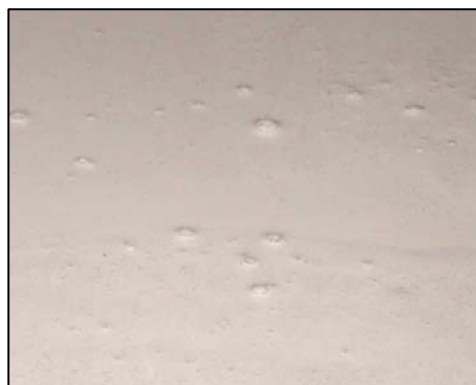
Foto 10: Neodstraněné bublinky vzduchu
