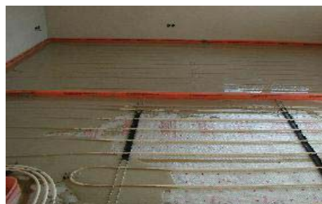
Foto 13: Lití potěru do ¾ výšky průřezu
