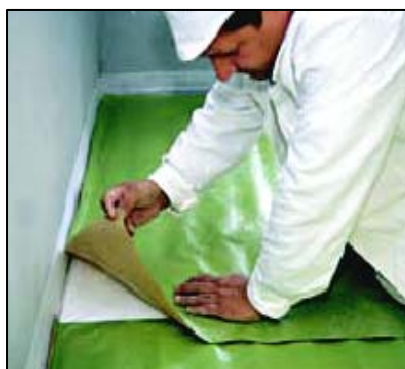
Foto 7: pokládání separační fólie na integrovanou fólii okrajové dilatační pásky
