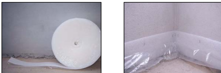
Foto 3, 4: okrajová dilatační páska s integrovanou fólií
