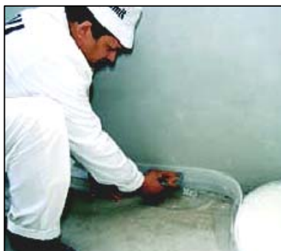
Foto 5, 6: montáž okrajové dilatační pásky, pokládání tepelně izolačních desek
